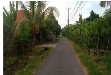
Gambar 8. Jalan dari Arah Selatan
